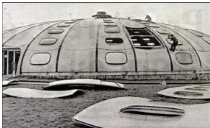
En avril 1988, la Ville de Briey posait des tuiles neuves sur sa piscine façon coupole. Photo Archives RL
