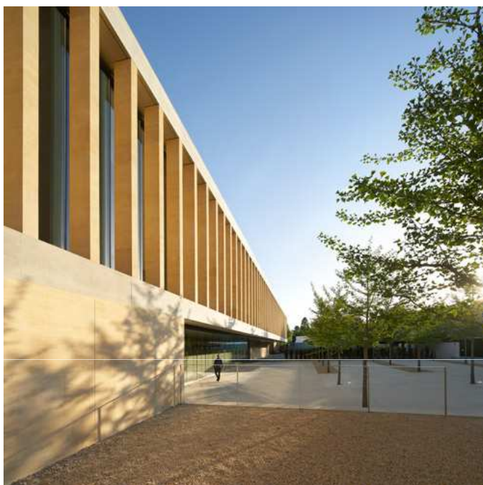
Laboratoire Sainsbury Université de Cambridge, Angleterre Architectes: Gavin Henderson, Stanton Williams Fournisseur pierre : Carrière de Jaumont
